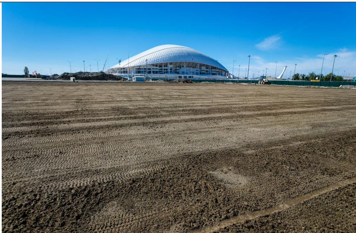
Вид готового основания
