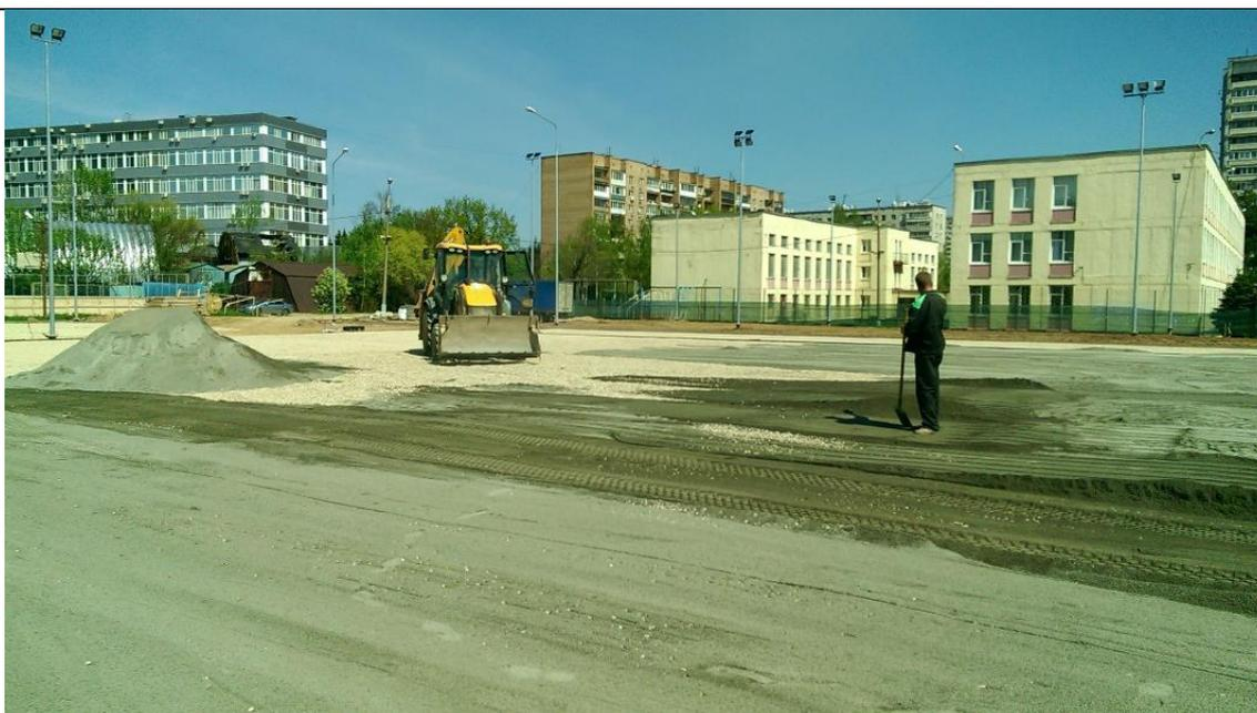
Использование лазерного планировщика в качестве бульдозера (для подсыпки грунтов)
