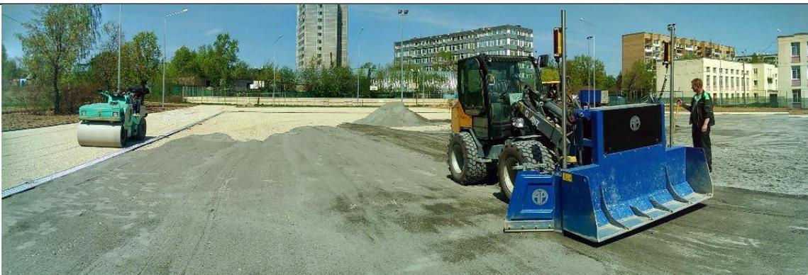
Для эффективной работы лазерного планировщика используется дополнительная техника (дорожные катки и крупнотоннажные бульдозеры)
