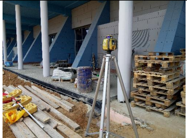
Шаг 4-й. Монтаж и настройка ротационного лазерного нивелира TOPCON
