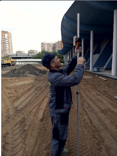
Шаг 5-й. Монтаж лазерного приемника на телескопическую рейку.
